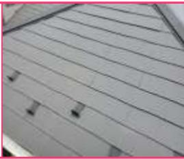
セメントに繊維質原料、けい酸質原料、混和材料などを混ぜたものを加圧成形した屋根材で**塗装が必要**です。
