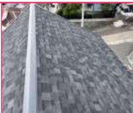
ファイバーグラスマットとアスファルトで構成され粒状彩色石を吹付けてある屋根材で**塗装が必要**です。
