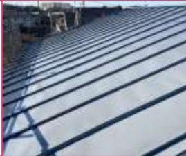
薄い鉄に亜鉛メッキ加工を施した金属屋根で**塗装が必要**です。
