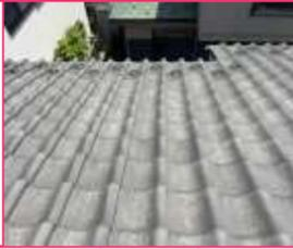
粘土を同じ形に形成し窯で高温により焼き固めた屋根材で塗装は**不要**です。
