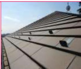
粘土とセメントを混ぜて形成した屋根材で**塗装が必要**です。
