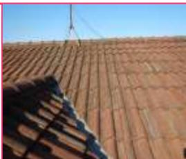
セメントと砂を混ぜて形成した屋根材です。陶器ではないので**塗装が必要**です。
