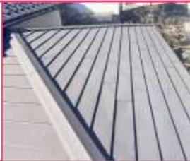
鉄素材にアルミ、亜鉛、シリコンで構成された合金でメッキされた金属素材屋根で**塗装が必要**です。
